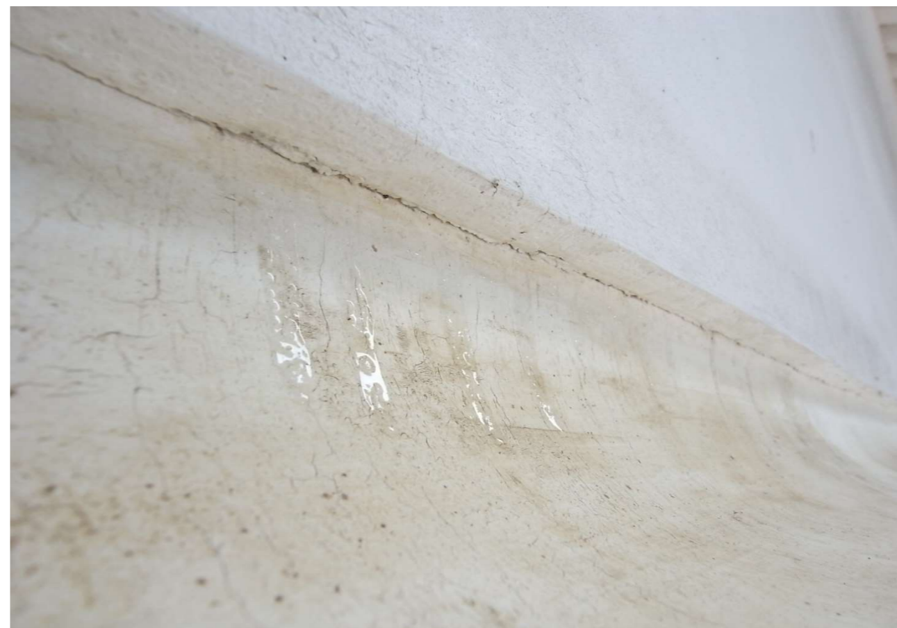
水切り上の壁張り出し、入隅の亀裂
