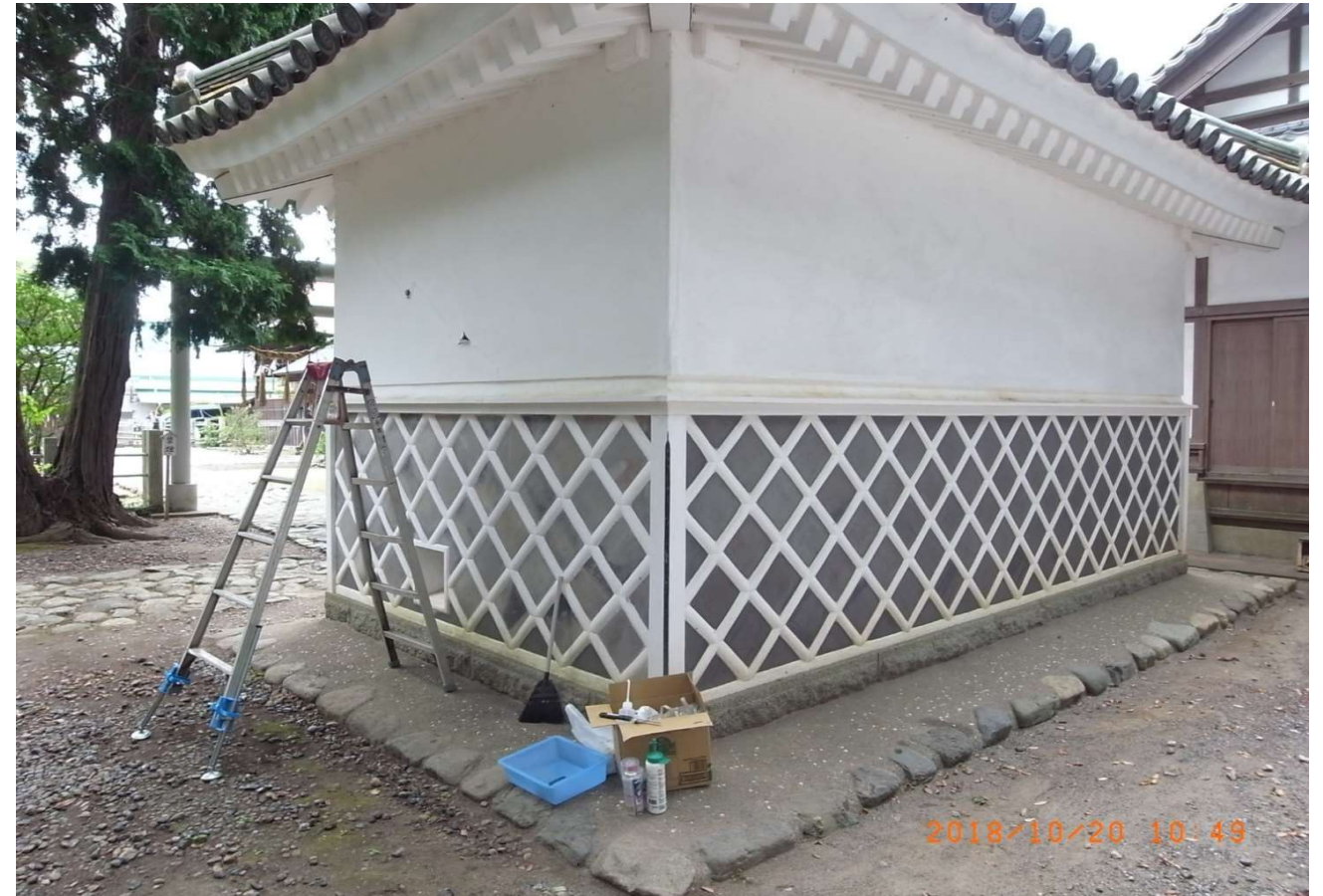
平成30年 亀裂補修 4 - 1
