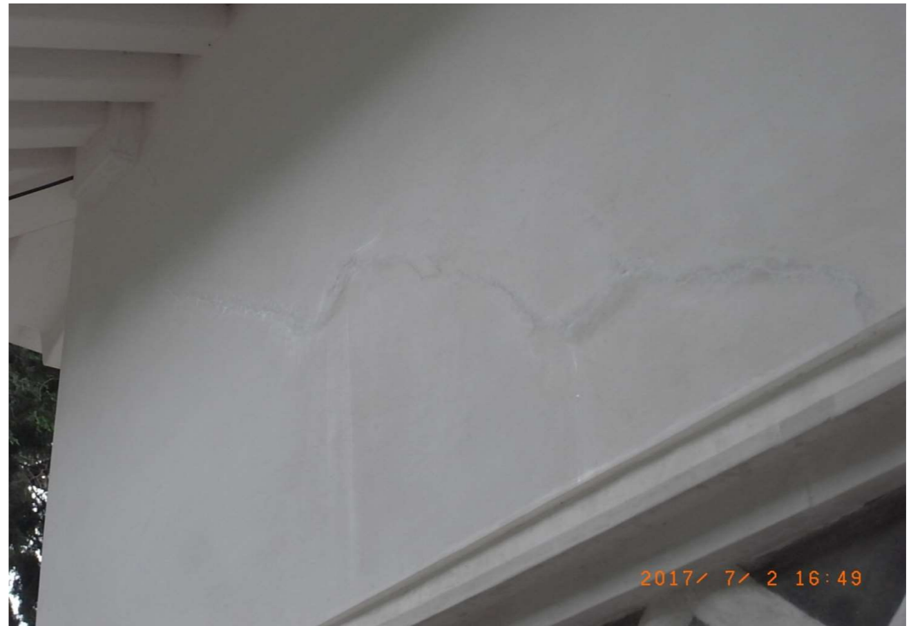
平成29年 亀裂補修 3 - 1
