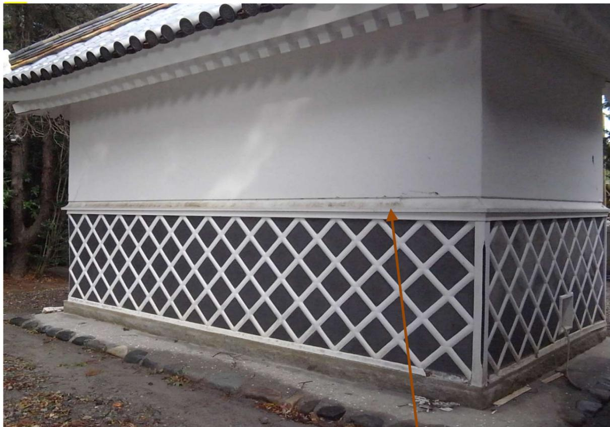
※水切り上の汚損は落下した下塗土
