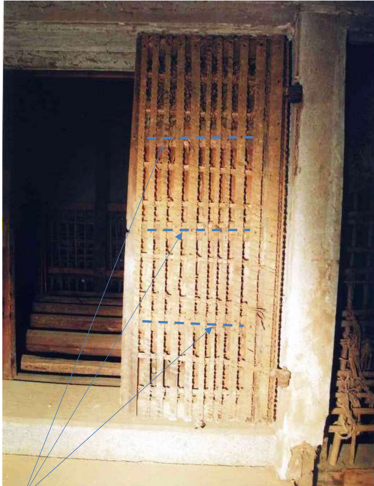
資料02 土扉の下地 (棧唐戸に縄巻下地を釘止めして土扉に改造)
