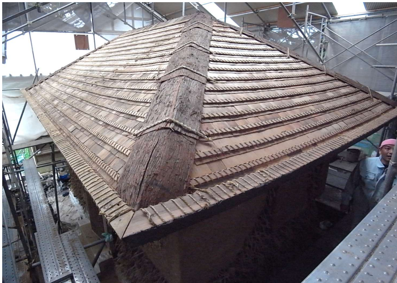
組立02 (屋根下地)
